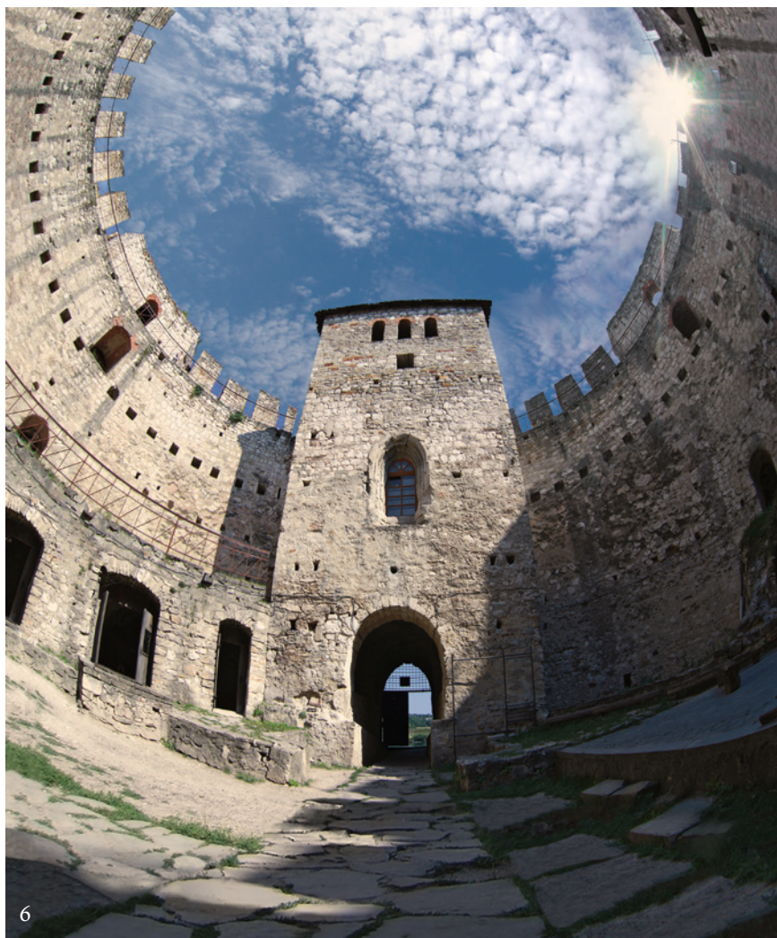
Cetatea Soroca 6. Vedere din interior. Turnul de poartă
