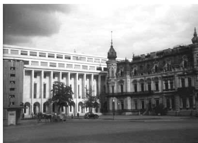
Consiliul de Miniștri, clădire construită între 1937 și 1944, aici înainte de demolarea Palatului Sturdza (unde se afla sediul Ministerului Afacerilor Străine)
